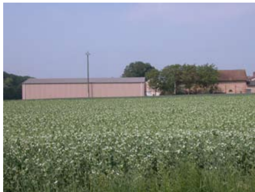
Bâtiment agricole implanté en cohérence avec le bâti existant, et dans les tonalités de couleurs adaptées. Il ne manque que quelques arbres d'accompagnement (Chaumot, près de Villeneuve-sur-Yonne)
