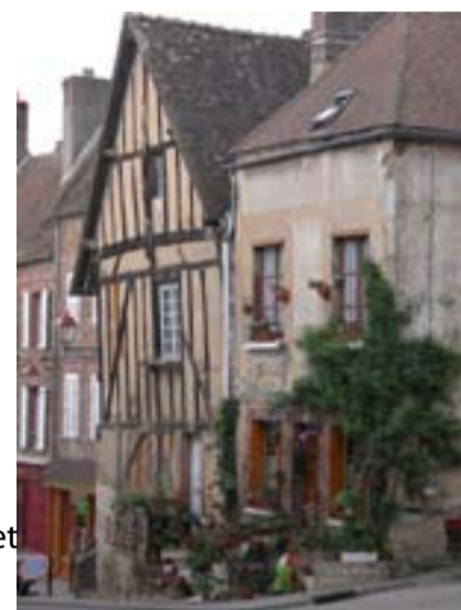
Couleurs denses et chaudes du bâti ancien réhabilité à Toucy
