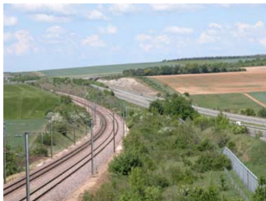
Dans l'Yonne, des grandes infrastructures nombreuses (ici l'A5 et le TGV vers Michery), mais une intermodalité à développer
