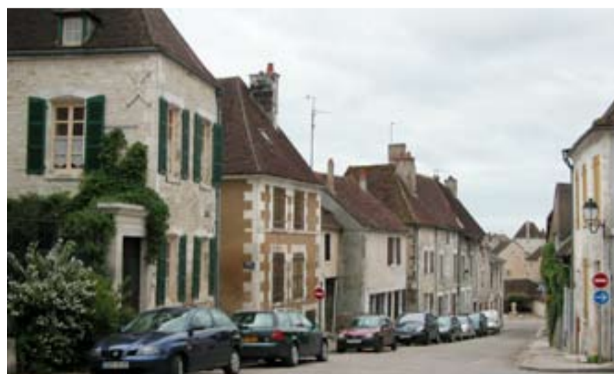
Patrimoine bâti en cœur de village, à Cravant (confluence Cure/ Yonne)
