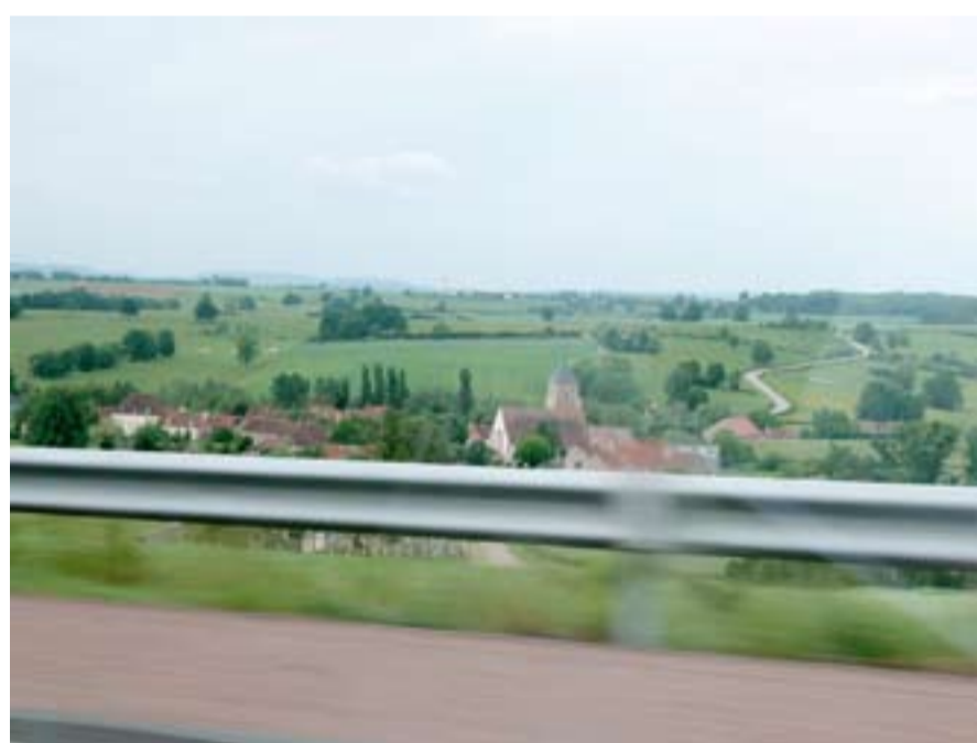
La préservation des abords des grandes infrastructures garantit l'ouverture sur les grands paysages, tout en réglant le problème des « entrées de villes » (urbanisme commercial). Ici l' A6, vers Avallon
