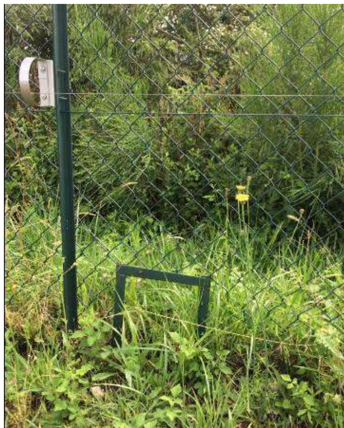
Figure 18 : Photographie de la clôture et du passage à faune (EDF Renouvelables)
