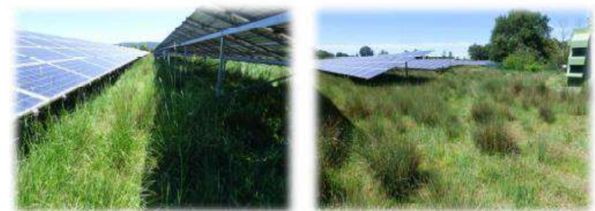
Pâturages humides à joncs observés sur le parc photovoltaïque
