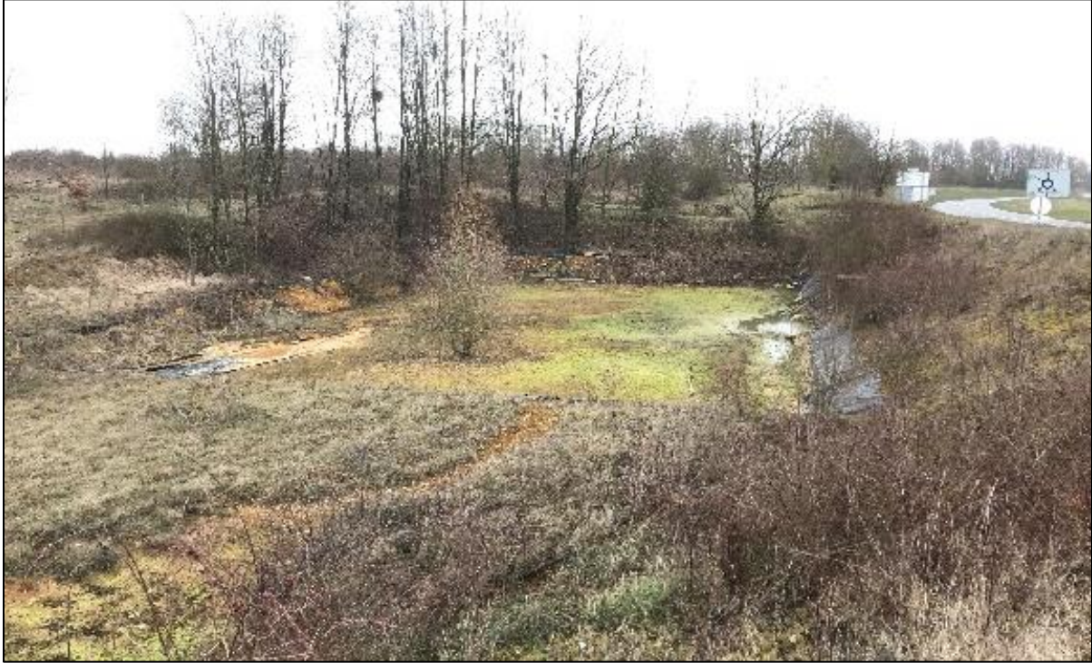
Figure 1 - Bassin de rétention d'eau avant travaux (EDF Renewables France - photo du 5 novembre 2018)
