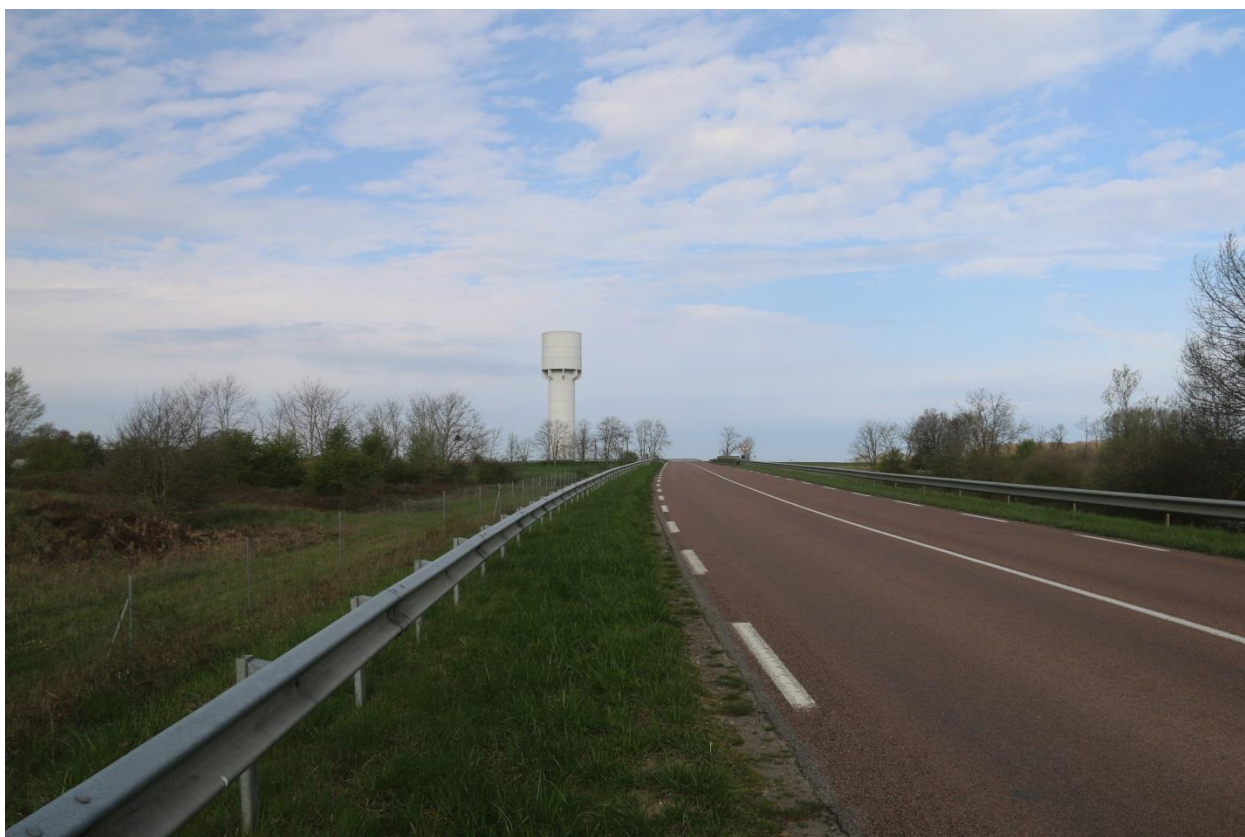
Prise de vue 5 : vue dégagée sur la RD 369 au droit du futur accès, photographie prise le 02 avril 2019
