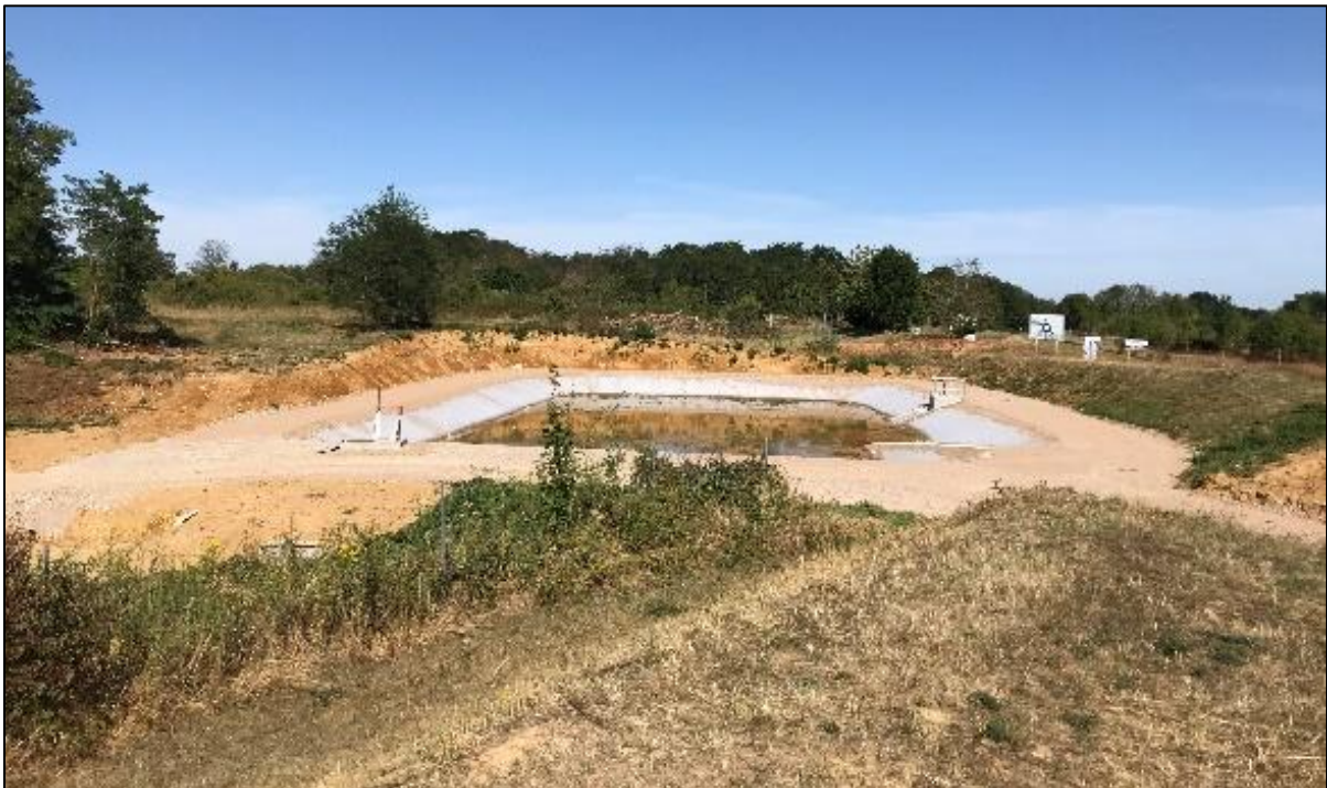
Figure 2 - Bassin de rétention d'eau après travaux (EDF Renewables France - photo du 22 août 2019)
