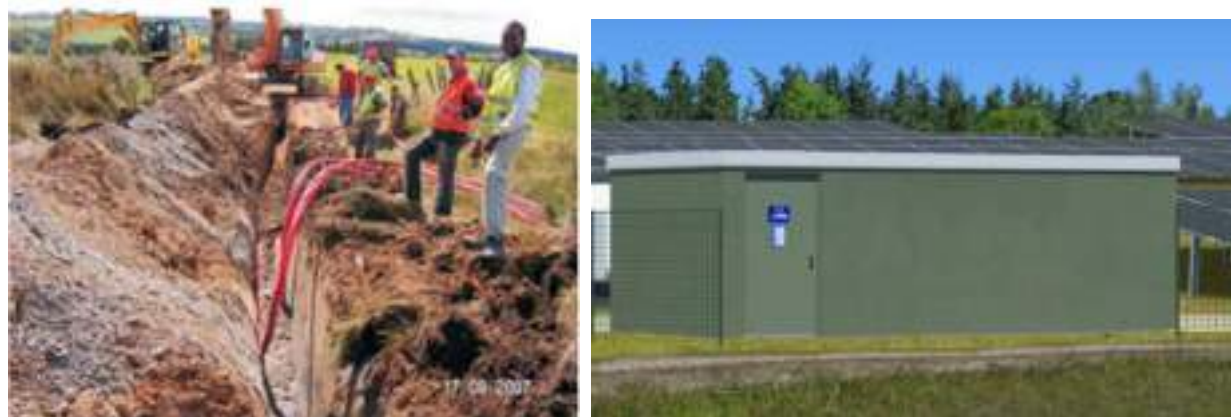
Photographie 6 : Déroulage/pose des câbles en tranchée et exemple de poste de livraison (EDF Renouvelables)
