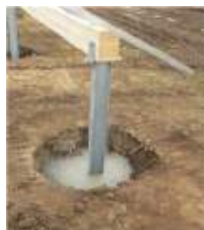
Photographie 4 : Exemples de pieu (EDF Renouvelables)
