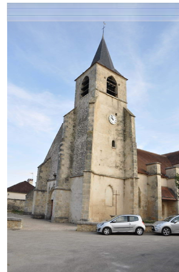
Photographie 17 : Eglise Saint-Christophe à Nitry, en cœur de village, pas de visibilité vers l'AEI (ES, le 20/09/2018)
