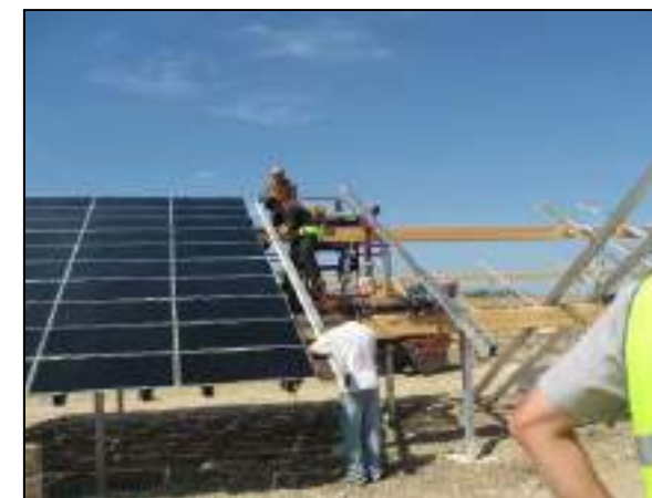
Photographie 5 : Montage de modules sur des supports fixes (EDF Renouvelables)
