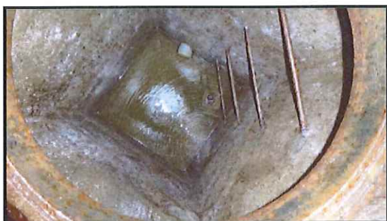
Intérieur de l'ancien captage (n°2)
