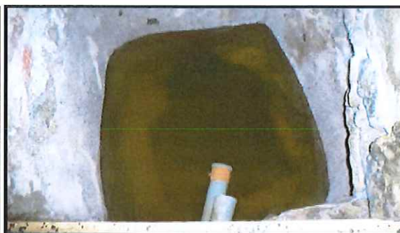
Captage de l'ancien Lavoire (déconnecté)
